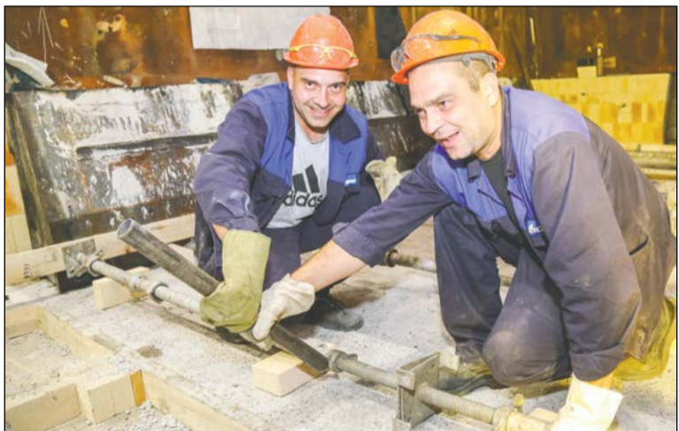
Братья Евгений и Алексей Садовы начали установку металлической опалубки для заливки огнеупорного слоя
