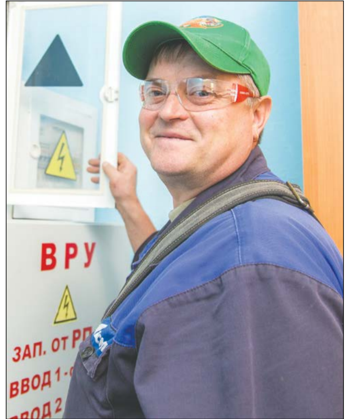
Сергей Акуленков удовлетворён состоянием силового щитка в «Престиже»
