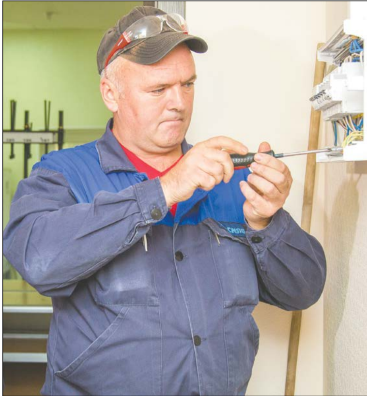
Андрей Булло завершает монтаж щитка в новом кабинете Дома книги
