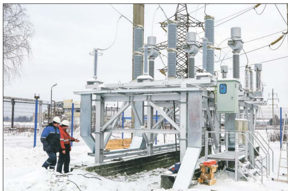
Новый блок-модуль смонтирован
