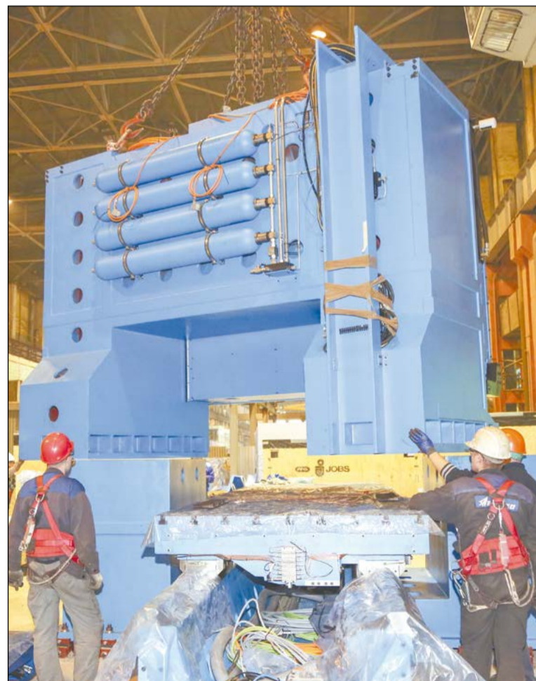
Транспортировка и установка траверсы
