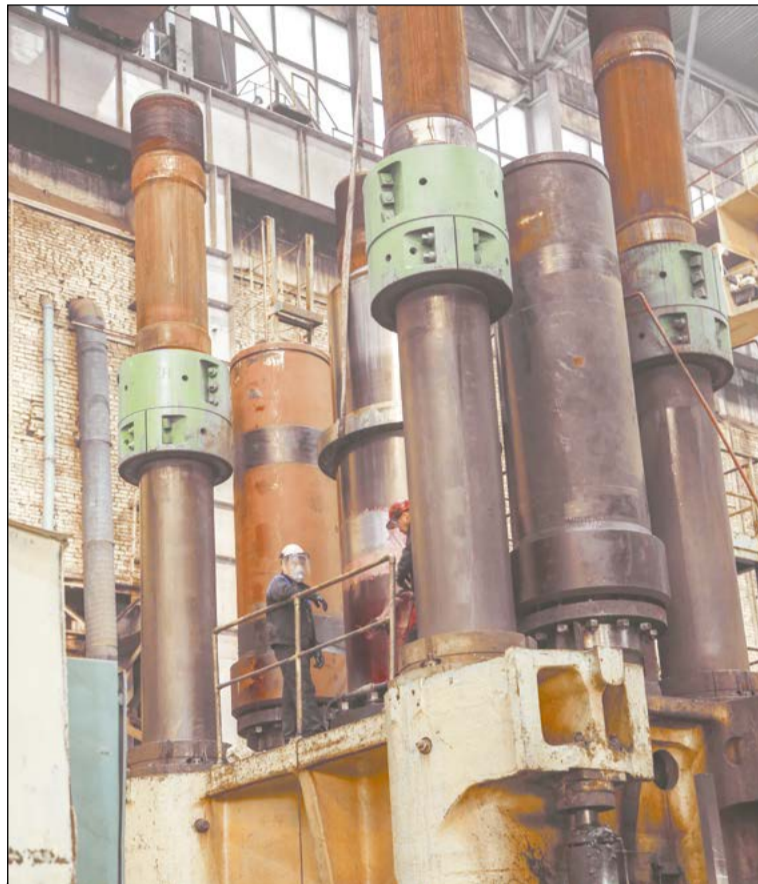
Слесари-ремонтники цеха № 50 готовятся к установке корпуса плунжера
