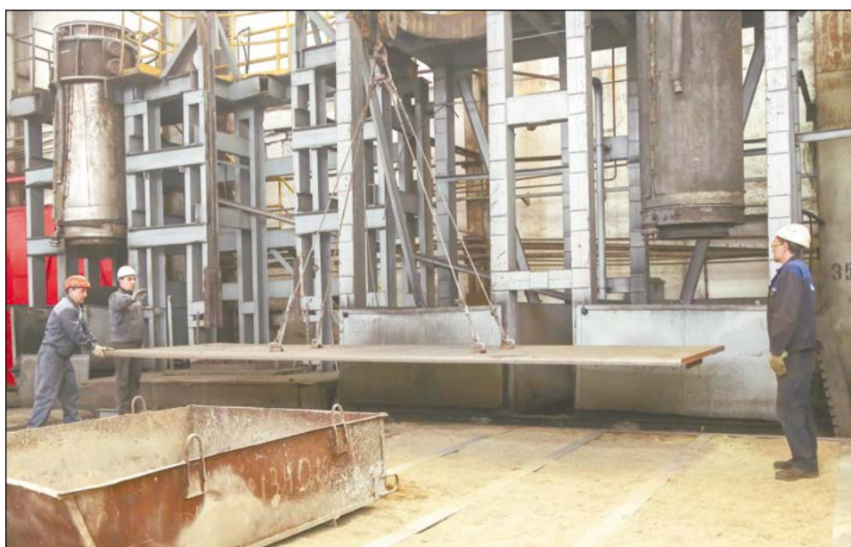
Стальной лист укладывается на подготовленный металлокаркас
