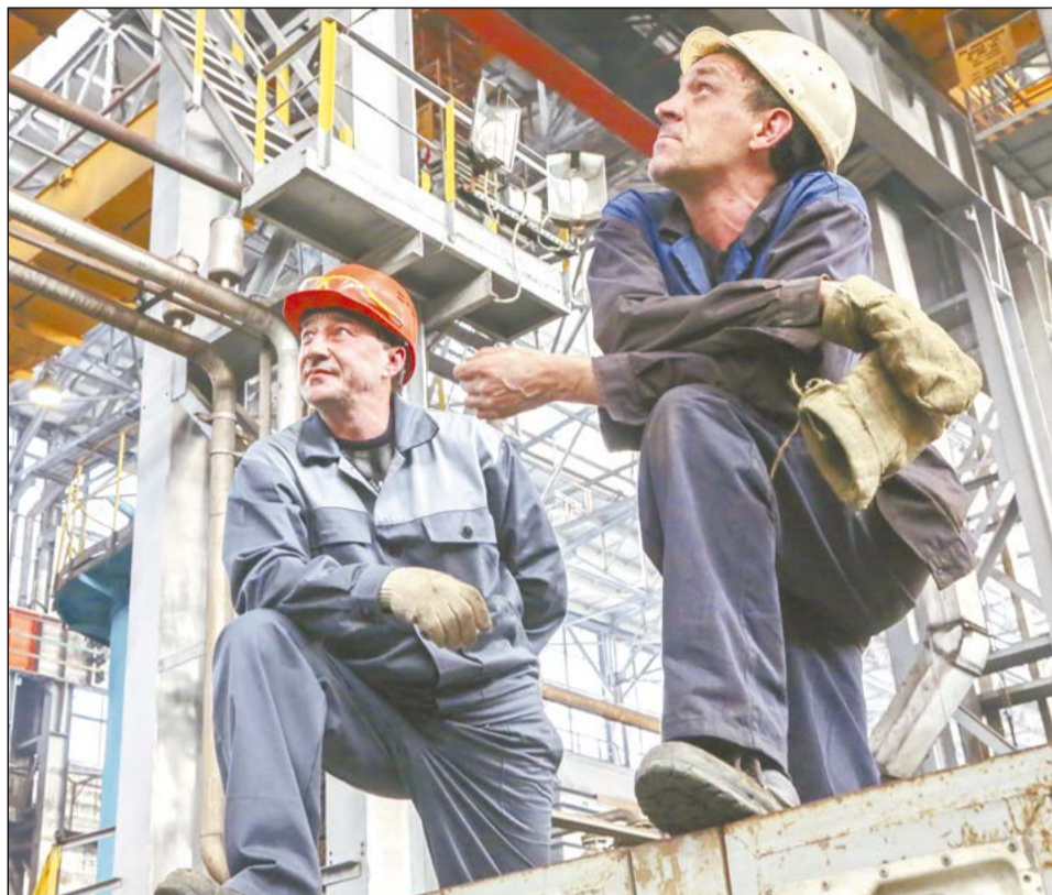
Александр Зорин и Александр Шепоренко, монтажники УКСа, в ожидании крана для транспортировки стальных листов
