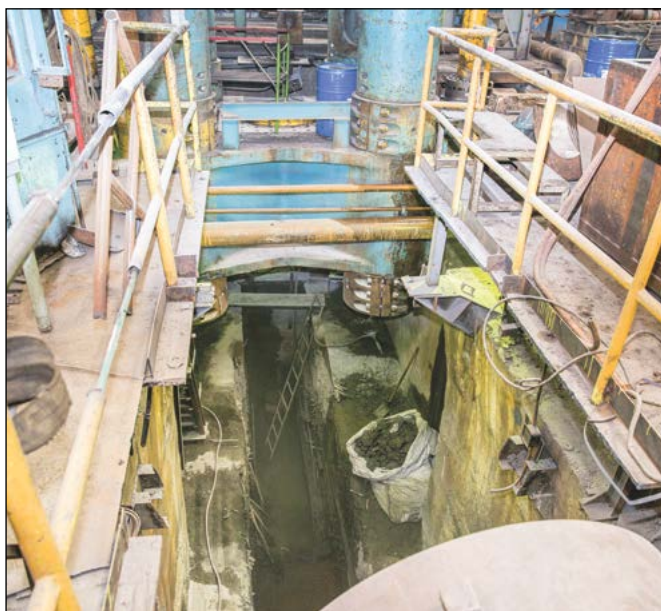
Подвал зоны выгрузки
