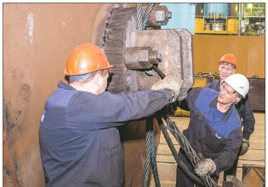
Слесари-ремонтники цеха № 50 кантуют главный цилиндр пресса
