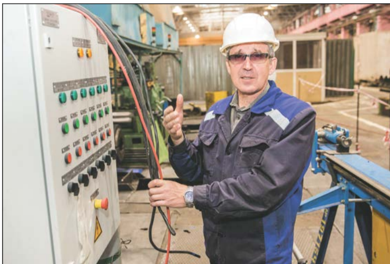
Сергей Киргизов, электрик отделения: «Кроме электроприводов, меняется ещё и гидравлика»
