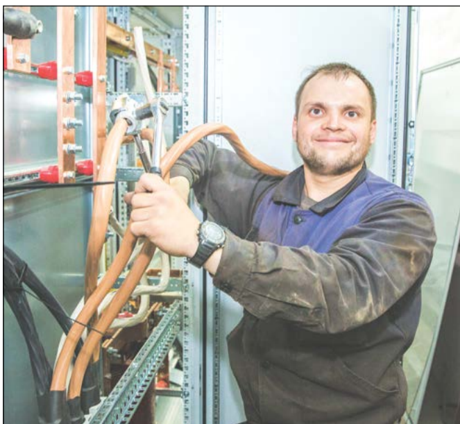
Константин Ермолаев, электромонтёр цеха № 6, проводит разделку силовых кабелей
