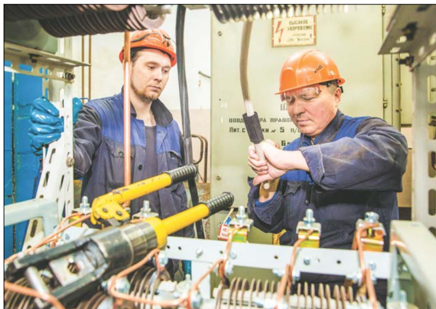
Виктор Смирнов и Стас Корпаков, электромонтёры цеха № 6, собирают систему тормозных сопротивлений главных приводов
