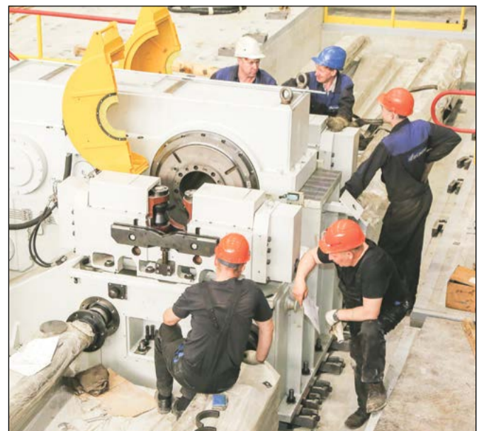
С первых дней монтаж идёт полным ходом
