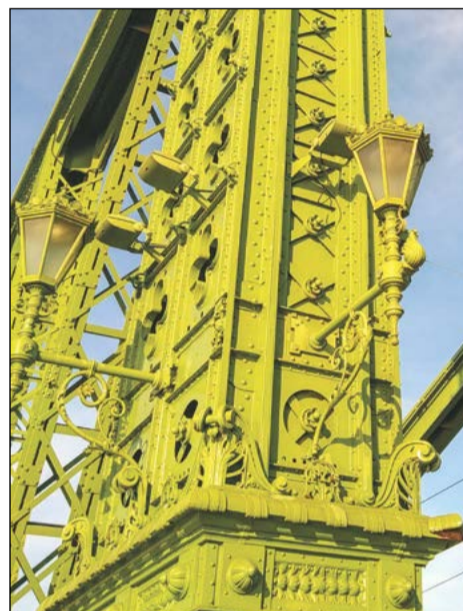
Мосты через Дунай были восстановлены сразу после войны
