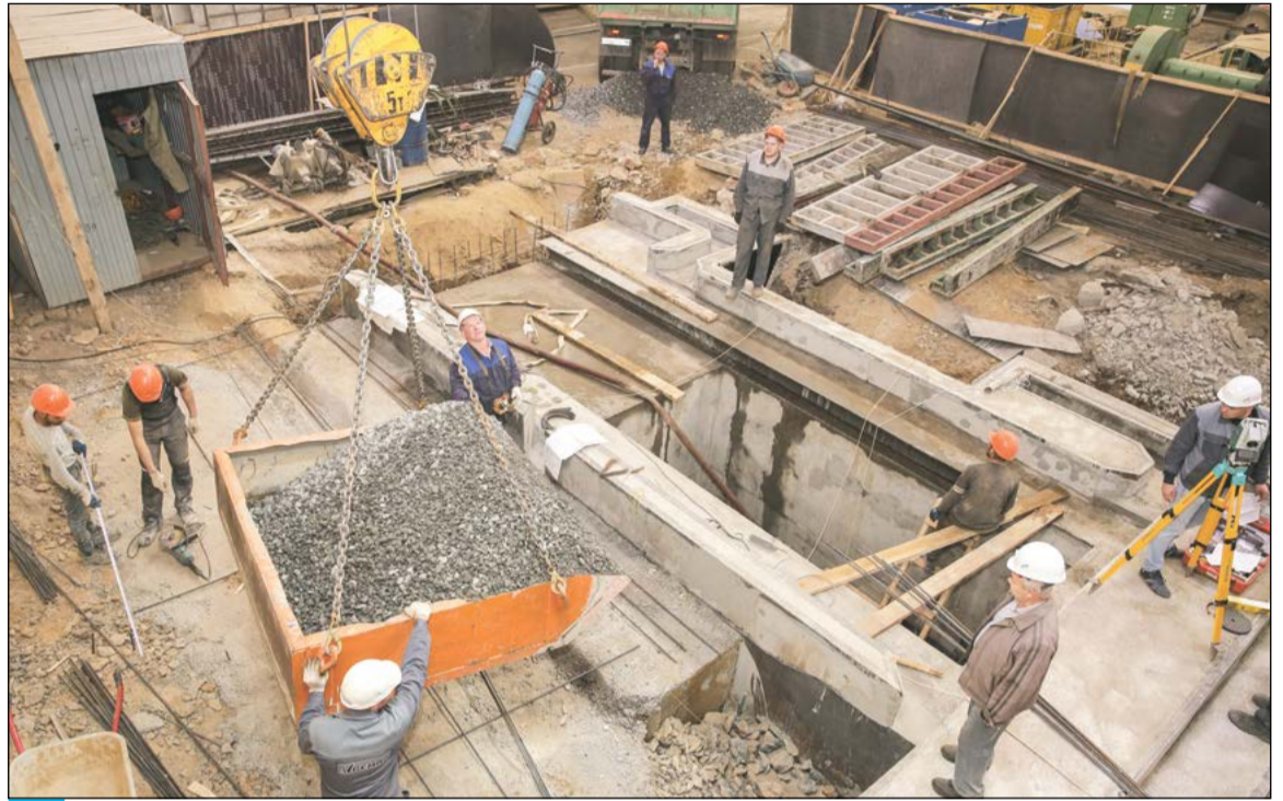
Обратная засыпка – последний штрих перед заливкой полов
