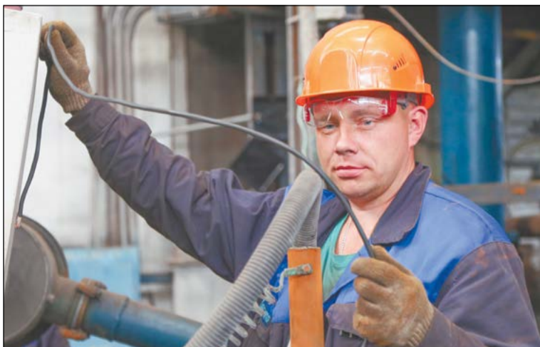
Электромонтёр цеха № 32 Денис Абашев монтирует новую схему насоса
