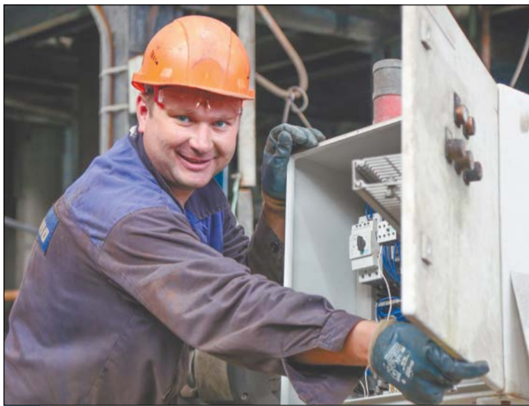
Электромонтёр цеха № 32 Александр Филатов ремонтирует автоматическую систему управления насоса
