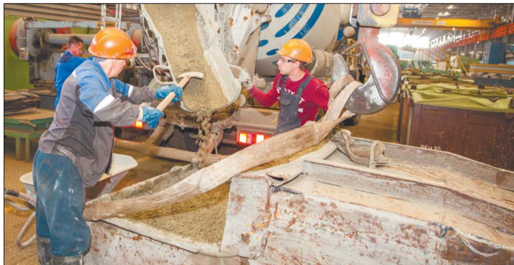
Бетон пошёл! Принимай! Не зевай!
