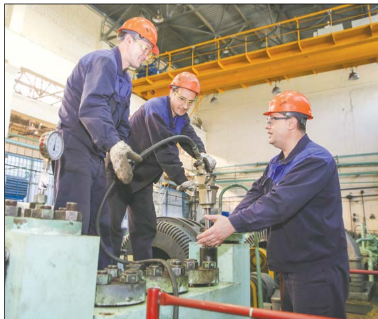
Евгений Новиков, Иван Добротин и Павел Котелевский разбирают клапанную коробку на насосе
