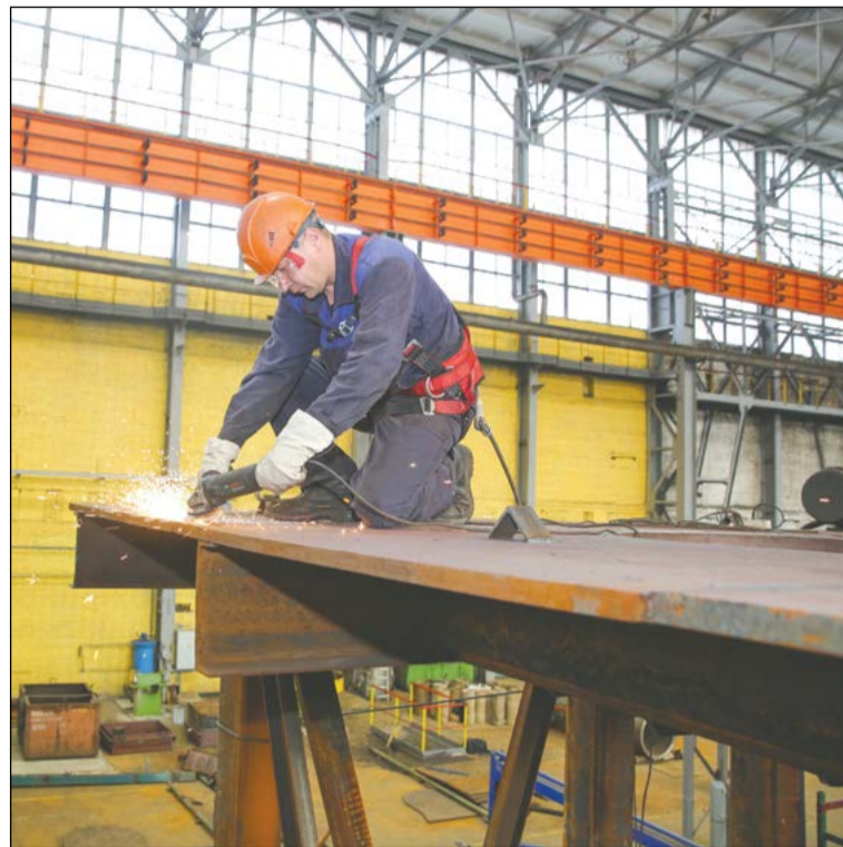
Слесарь-ремонтник Иван Нестерюк и его углошлифовальная машина приводят сварные швы в порядок
