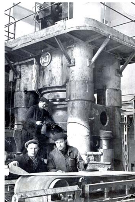
стка Ю.Бахтин и электромонтер М.Камалдинов.
