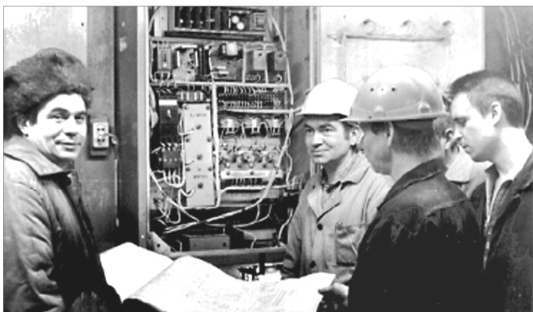
Бригада под руководством В.Алексеева вела реконструкцию оборудования на участке ОКИ первого цеха.
