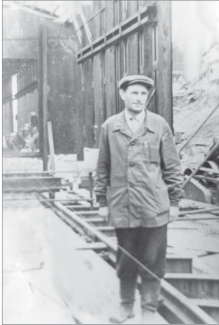
Техник-строитель Михаил Исакович Бай у строящейся туннельной печи.
