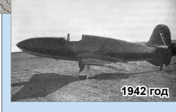
Самолёт БИ-1 (Березняк и Исаев) — экспериментальный истребитель-перехватчик с жидкостным ракетным двигателем. Самолет с цельнодеревянным корпусом имел необычно малые размеры: размах крыла 6,48 м, длину 6,4 м. Скорость максимальная — около 800 км/ч. Вооружение: две пушки с 90 снарядами и 38 кг бомб. Была построена войсковая серия в восемь самолетов. Опыт немногочисленных полётов показал, что самолет БИ как истребитель принять быть не может из-за чрезмерно малой продолжительности полета.
