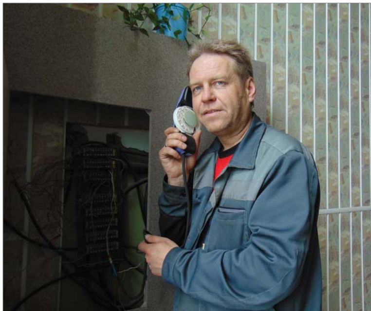
Проверка линии связи в инженерном центре.
