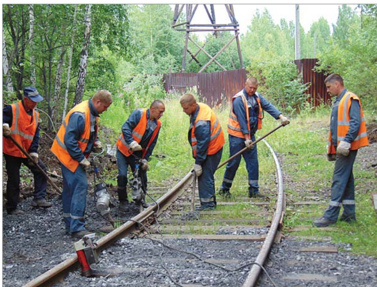
Бригада монтеров пути.
