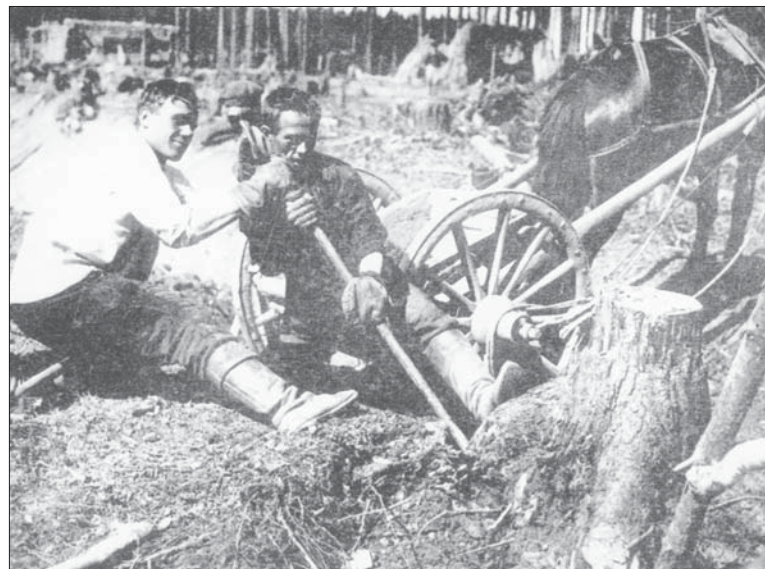
Стройка началась. 1929 год.
