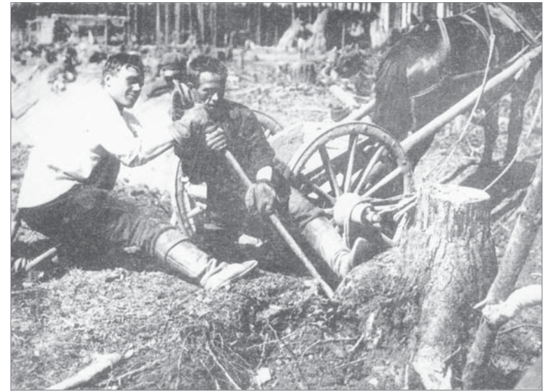
Стройка началась. 1929 год.
