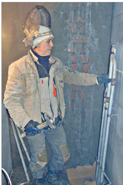
Михаил Плещенко обеспечивает надёжность водопроводных труб.
