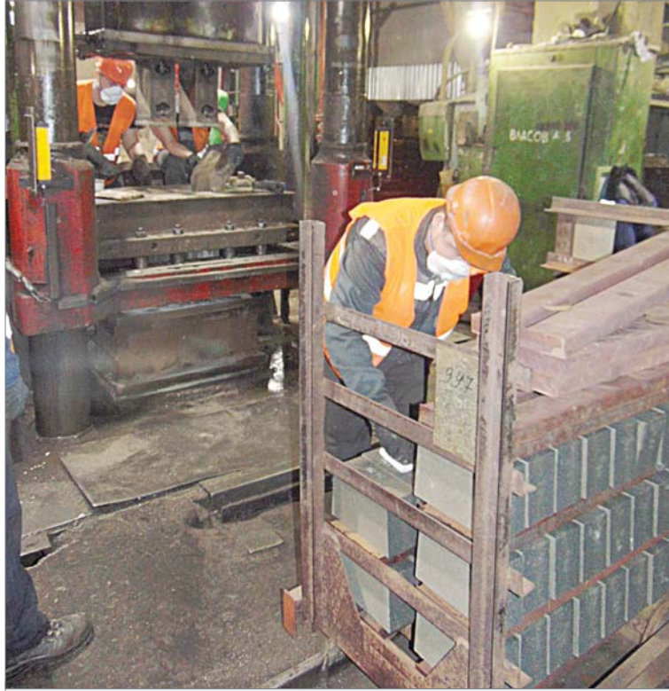
После демонтажа «Лайса» №4 на остальные прессы легла дополнительная нагрузка.
