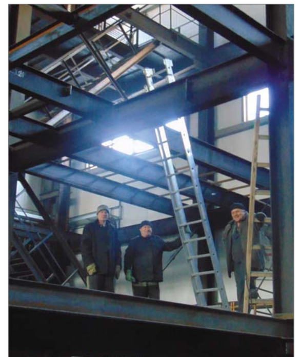
Три этажа металлоконструкций поднялись более чем на 8 метров.
