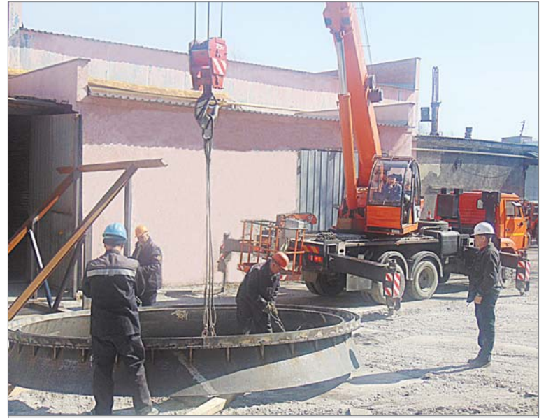
Строители и автотранспортники перевозят к месту монтажа верхний конус печи, сделанный специалистами механолитейного цеха.
