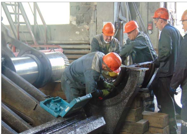
Идёт капитальный ремонт щёковой дробилки.
