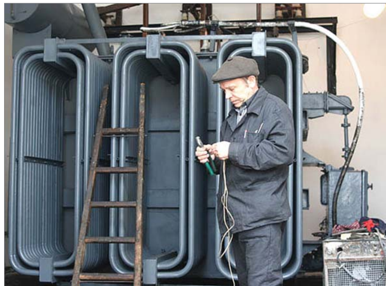
Дежурный монтер МЛЦ Александр Балдин тоже участвовал в капремонте тепломечи и трансформатора. 2004 год.
