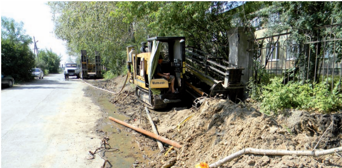
Установка горно- направленного бурения
