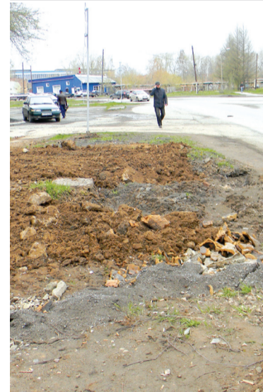
После ремонта теплотрассы
