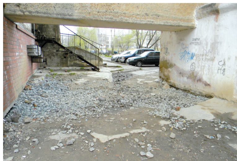
Траншея между домами завалена щебнем (ул. Воронова, 10)
