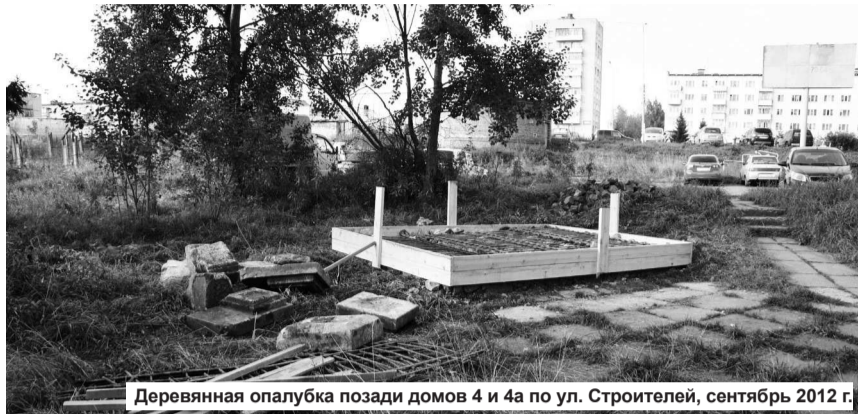
Деревянная опалубка позади домов 4 и 4а по ул. Строителей, сентябрь 2012 г.
