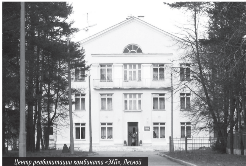
Центр реабилитации комбината «ЭХП», Лесной
