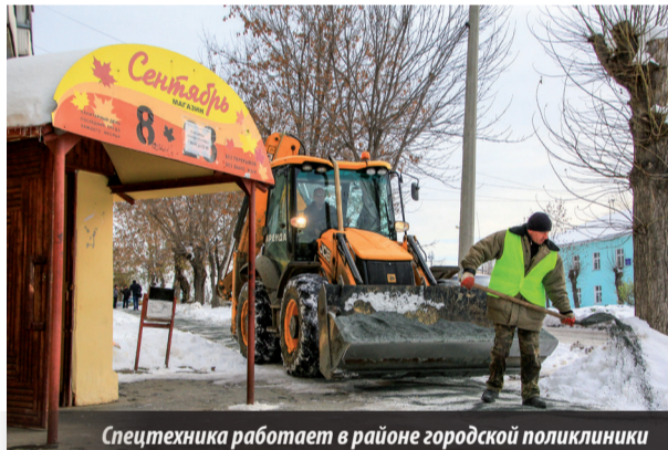
Спецтехника работает в районе городской поликлиники
