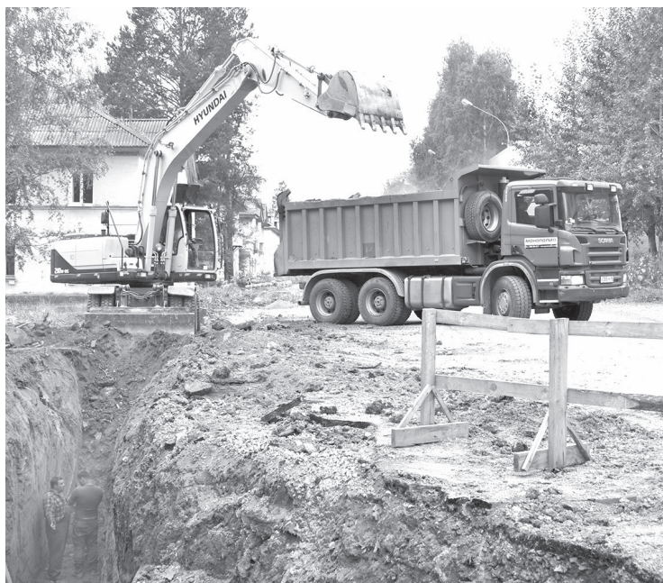
Нижняя Тура, земляные работы на улице Ильича. ФОТО АВТОРА
