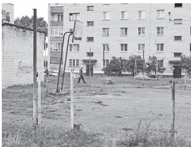
На месте детской площадки остались лишь ржавые трубы-стойки. ФОТО АВТОРА
