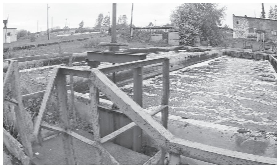
Отстойник очистных сооружений г. Лесного. ФОТО АВТОРА
