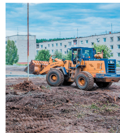
У здания бывшего ПЛ-22 идут строительные работы по обустройству нового школьного стадиона. ФОТО АВТОРА
