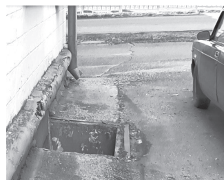
Углубления для подвальных окон лесничане используют для сброса туда мусора
