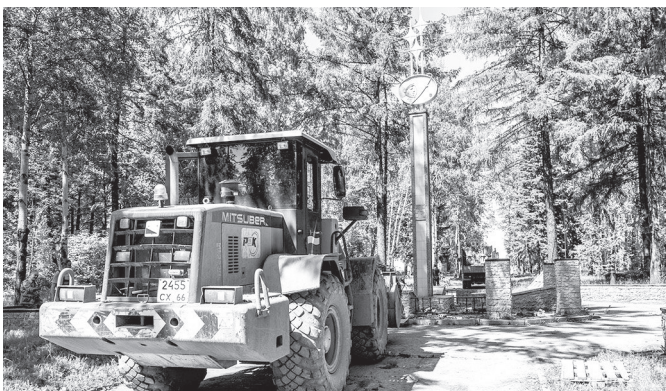
Демонтируется старое оборудование зоны отдыха
