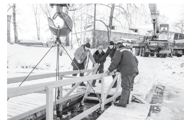
Ещё немного и работы будут завершены
