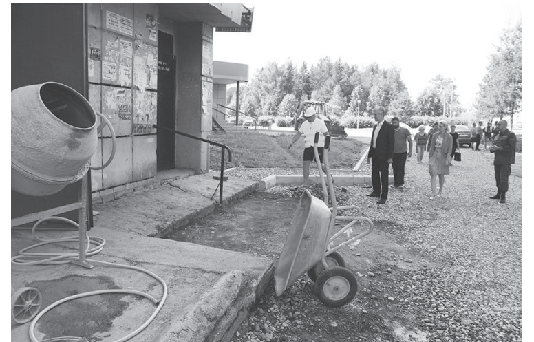
Комиссия оценивает ход работ у дома № 22 по ул. Мира
