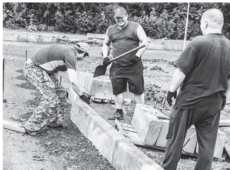
Дорожные работы на перекрёстке Энгельса - Победы
