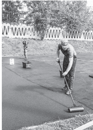
На стадионе школы № 76 идут ремонтные работы
