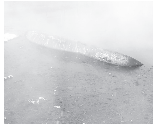
Сгнившее железо оборудования отстойника, центральные очистные города
