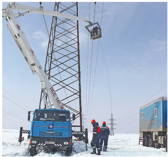
Линейные бригады во время учений заменили 2,5 тысячи изоляторов на линиях электропередачи 220 кВ.
