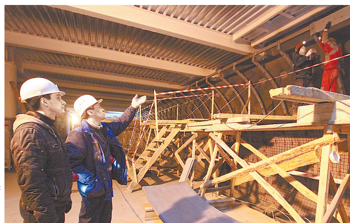
С вводом станции «Чкаловская» работа в Екатеринбурге для метростроителей закончилась.
