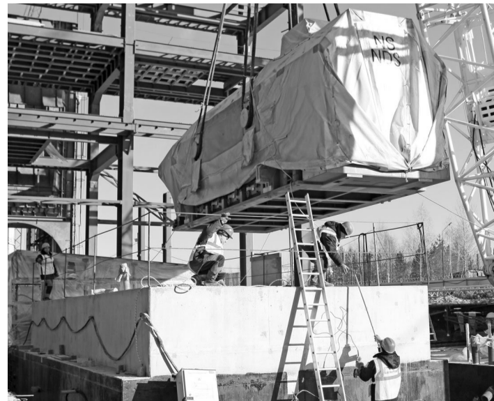
После долгого пути по морю, рекам и автодорогам «сердце» энергоблока установили на фундамент.
