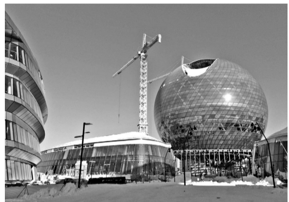
Шар диаметром 80 метров изготовлен с использованием металлоконструкций, произведенных в Зауралье.
