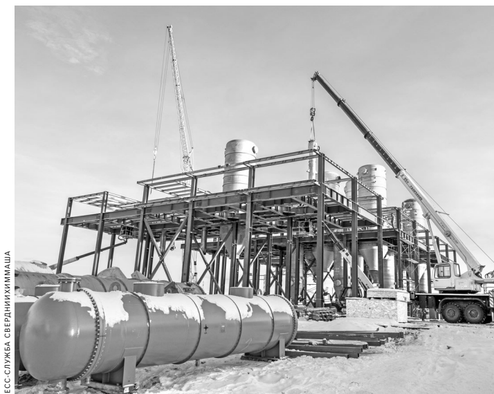
В здании «этажерки» монтируют 18 массивных сепараторов, в последующем это будет закрытый и утепленный производственный корпус.
