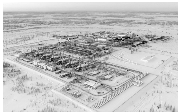
В прошлом году введена в эксплуатацию дожимная компрессорная станция на установке комлексной подготовки газа на Заполярном нефтегазоконденсатном месторождении, что позволит увеличить добычу газа на промысле на 30–35 процентов.
