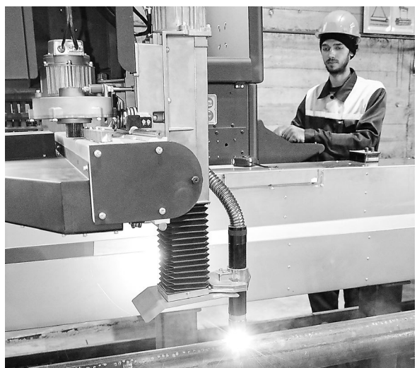
На открывшемся участке винтовых свай и трубчатых фундаментов будут выпускать в год около 2400 тонн металлоконструкций.
