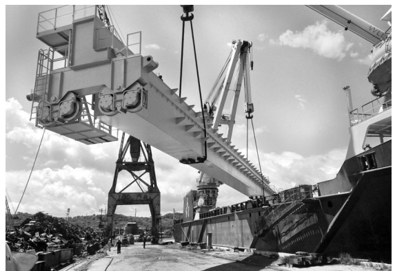
Оборудование погружено на теплоход «Богатырь», который доставит его заказчику.
