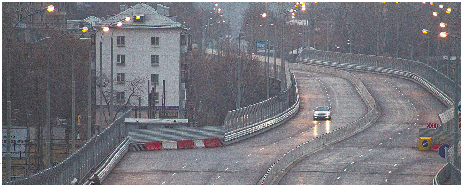
Дорожную развязку проложили на уровне четвертого этажа пятиэтажки, а жители первых этажей оказались лишены дневного света.
